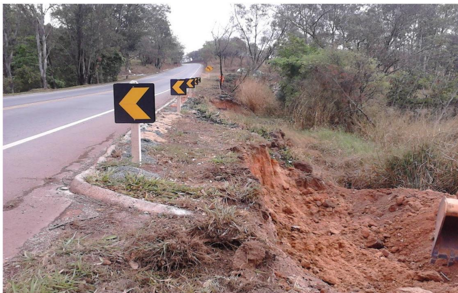
Vista do processo erosivo no km 112 (LD) - Antes
