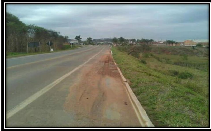
RODOVIA MG-050 KM 264,45 LD ANTES EVENTO 14960/14
