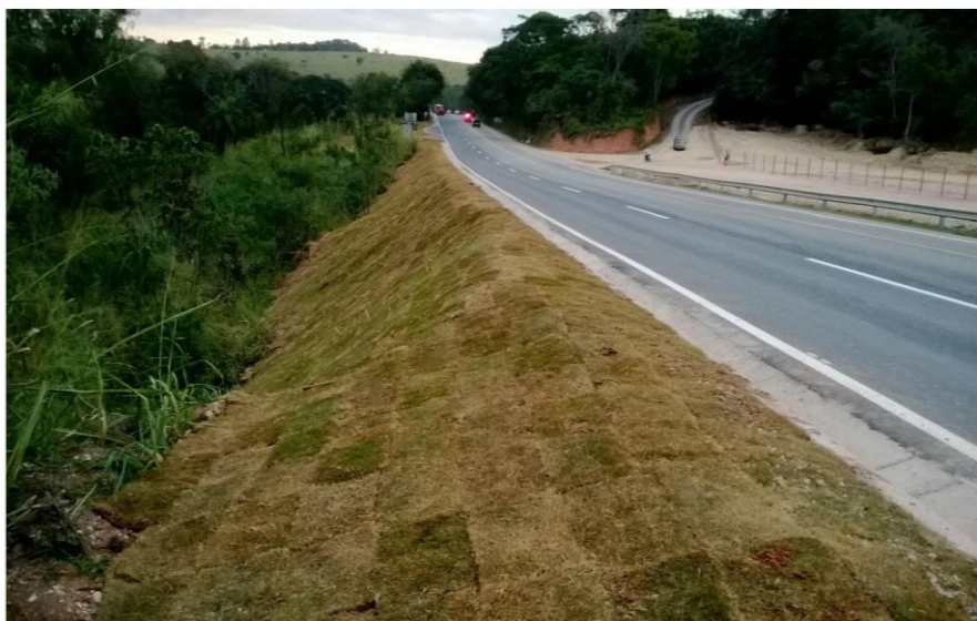
Revestimento vegetal (tipo grama em placa) executado em talude de aterro
