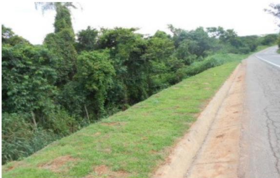
Vista do processo erosivo no km 199,50 (LE) - Depois
