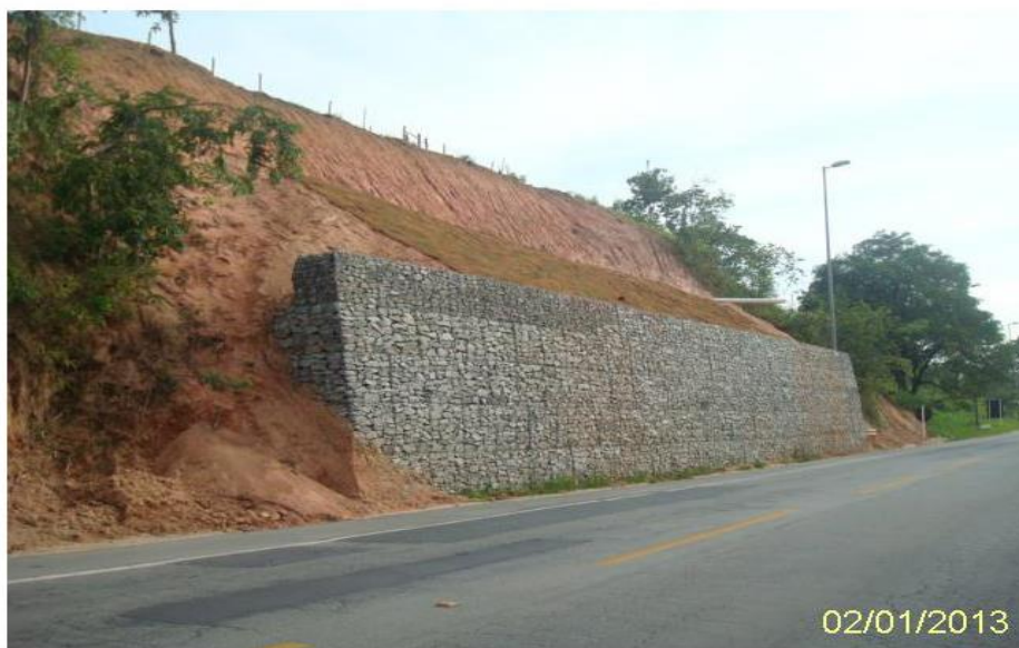
Vista do processo erosivo no km 131 (LD) - Depois
