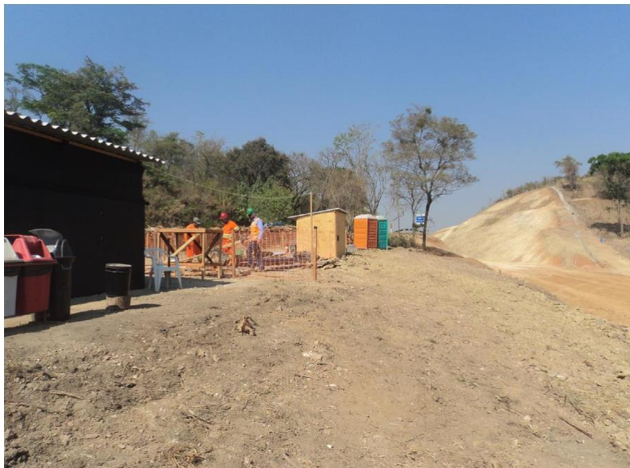
Foto 7.4.2.4-7: Canteiro de obras para a correção de traçado e implantação de 3ª Faixa (ITV 159-160) do Km 375,32 – 378,151.
