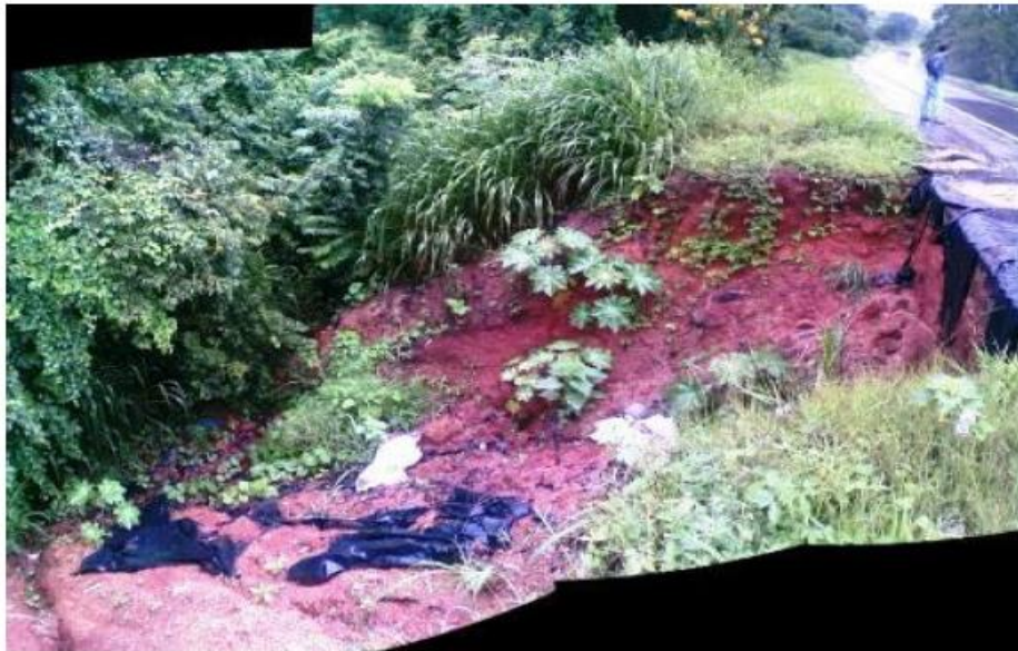
Vista do processo erosivo no km 199,50 (LE) - Antes
