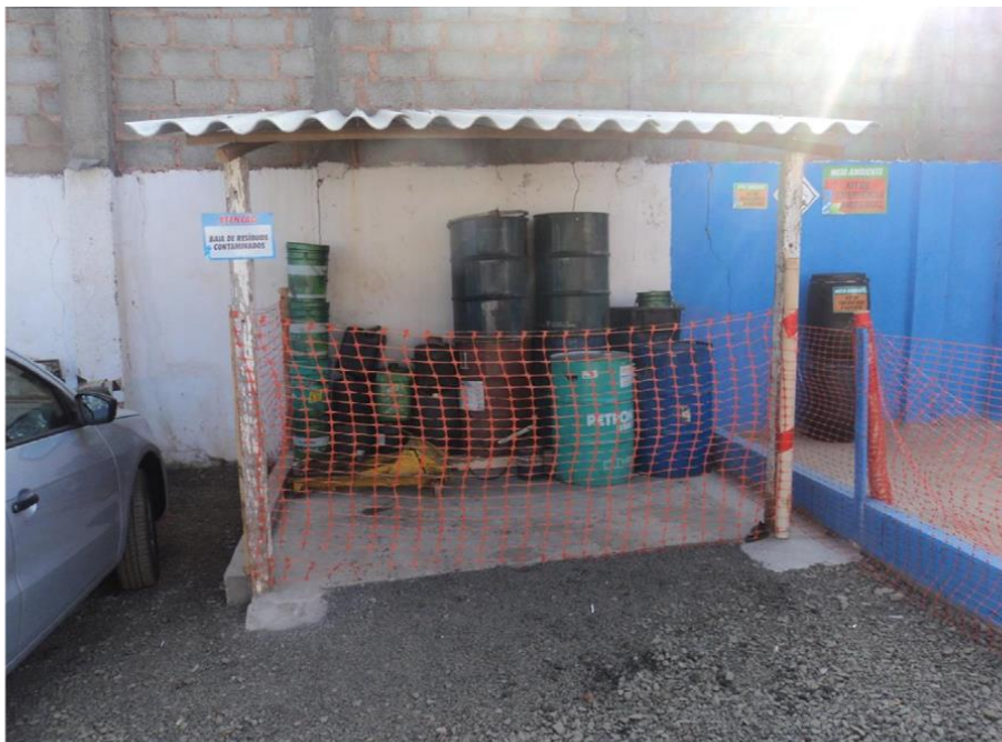
Foto 7.4.12.4-8: Baia de armazenamento de resíduos perigosos.
