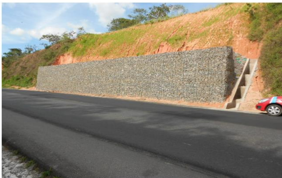
Vista do processo erosivo no km 170 (LE) - Depois
