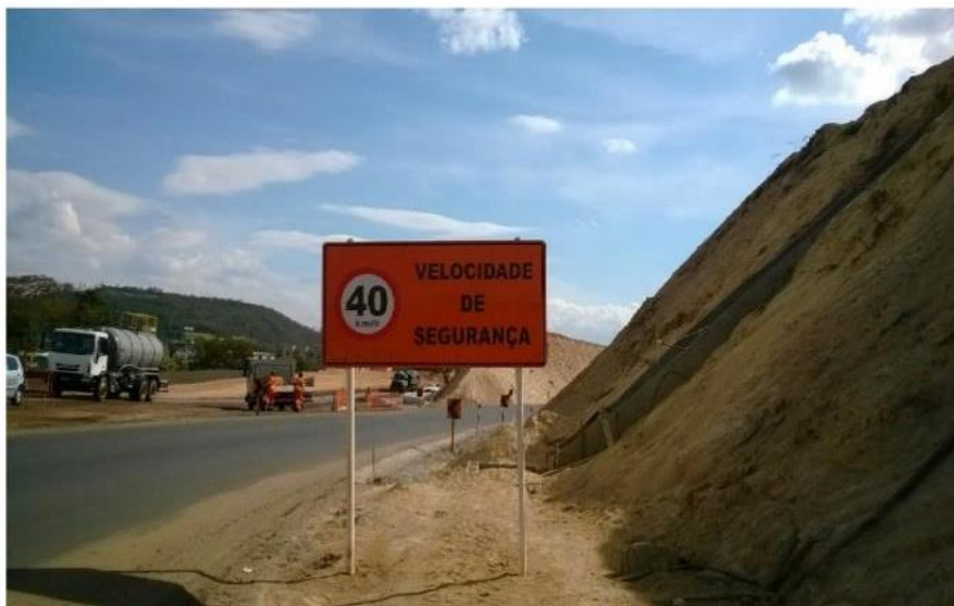
Vista das placas de limite de velocidade nos trechos em obras (ITV 27-31)
