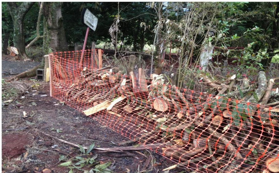
Vista do acondicionamento temporário de rendimento lenhoso da obra (o material é depositado em local aonde não oferece risco aos usuários da rodovia)
