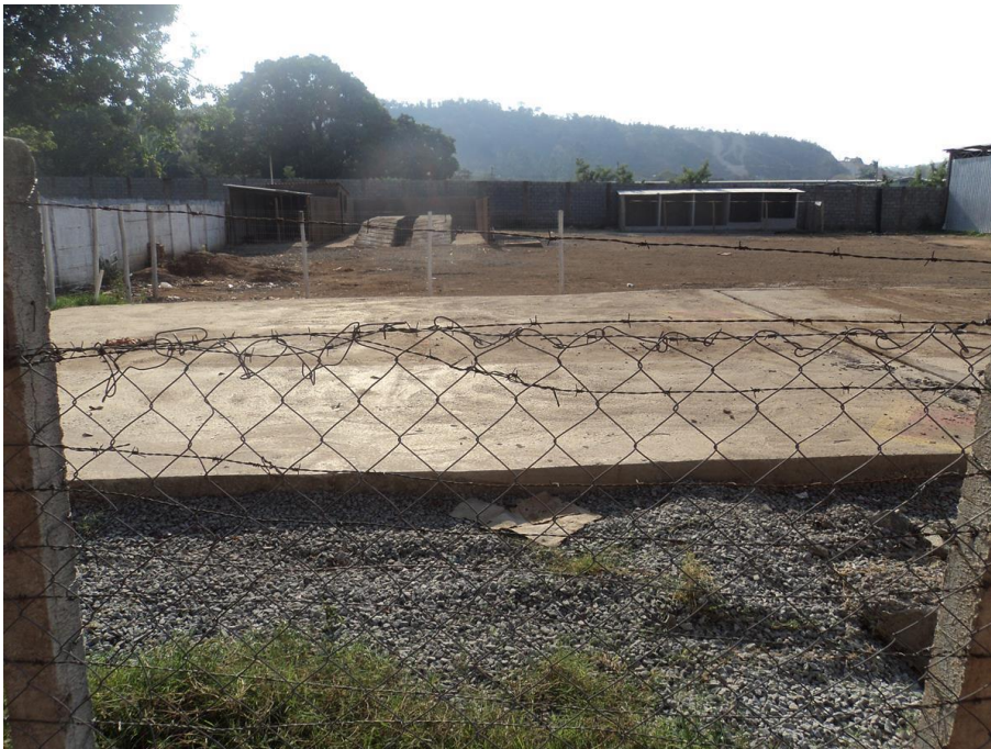
Foto 7.4.2.4-15: Canteiro de obras da ECB em Itaú de Minas desativado.
