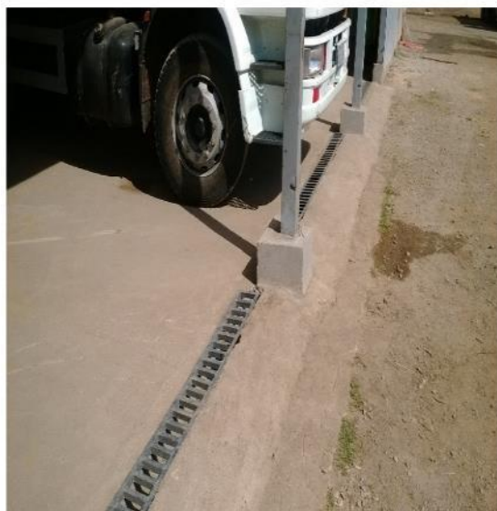
Vista do canteiro de obras da empresa ECB (Duplicação de Itaúna ITV 27-31) - detalhe da oficina que possui o piso impermeabilizado e entorno possui canaleta de drenagem ligada a caixa separadora de água e óleo
