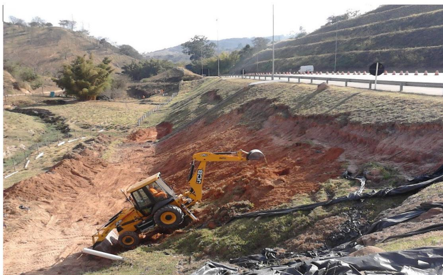
Vista do processo erosivo no km 81 (LE) - Durante a execução
