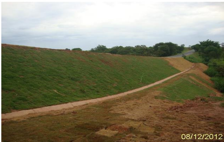
Vista da recuperação do processo erosivo no km 103 (LD) - Depois
