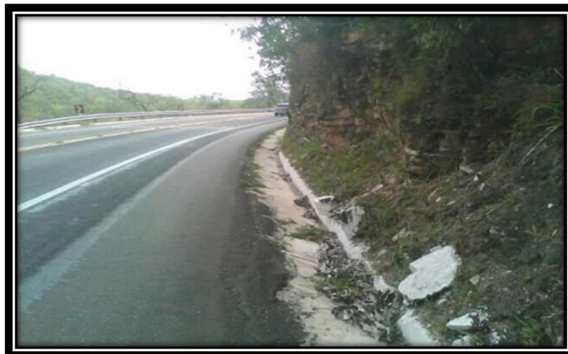
RODOVIA MG-050 KM 319,8 AO KM 320 LE ANTES EVENTO 14719/14
