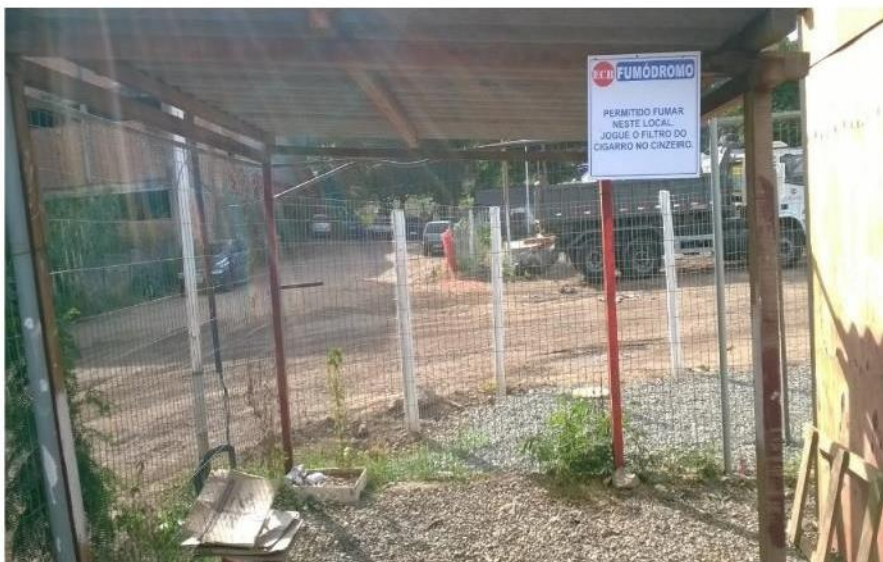
Vista do canteiro de obras da empresa ECB (Duplicação de Itaúna ITV 27-31) - detalhe no cercamento da área e espaço para fumantes
