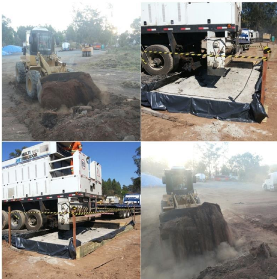
Foto 7.4.12.4-6: Correto procedimento de coleta e destino final do solo contaminado.
