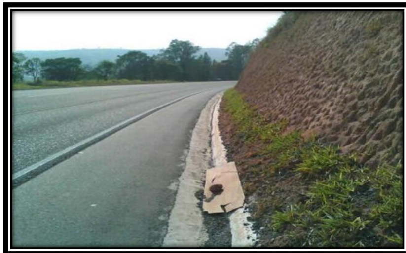
RODOVIA MG-050 KM 207,95 LE ANTES EVENTO 14627/14
