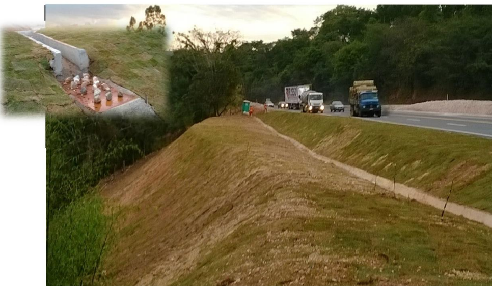
Revestimento vegetal (tipo grama em placa) executado em talude de aterro/ detalhe no dispositivo de dissipação de energia instalado no ponto à jusante da drenagem
