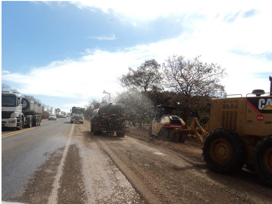
Foto 7.4.3.4-1: Umectação da via das obras de implantação da 3ª Faixa e correção de traçado (ITV 153-154) do Km 364,12 - 368,02 de responsabilidade da ECB.
