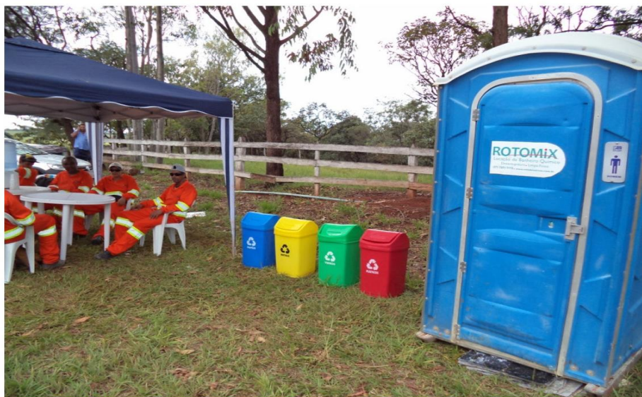
Lixeiras de coleta seletiva instaladas ao longo das obras e canteiros
