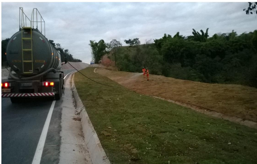
Vista da irrigação da grama plantada
