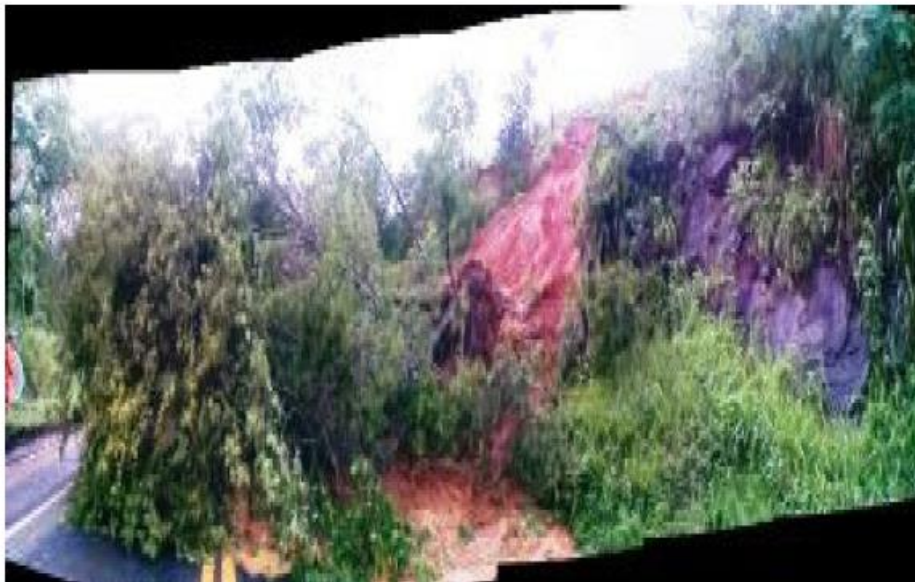
Vista do processo erosivo no km 221,50 (LE) - Antes
