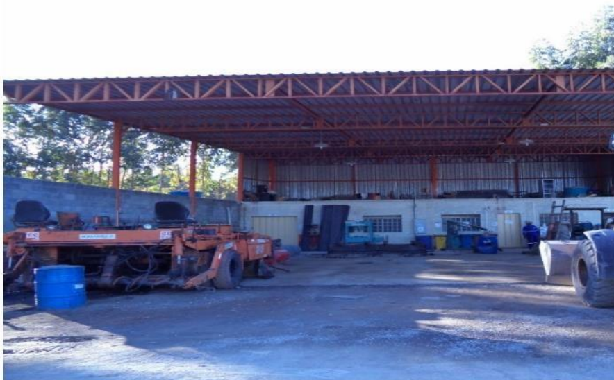
Vista do canteiro de obras da empresa Pavidez - detalhe da oficina com piso impermeabilizado
