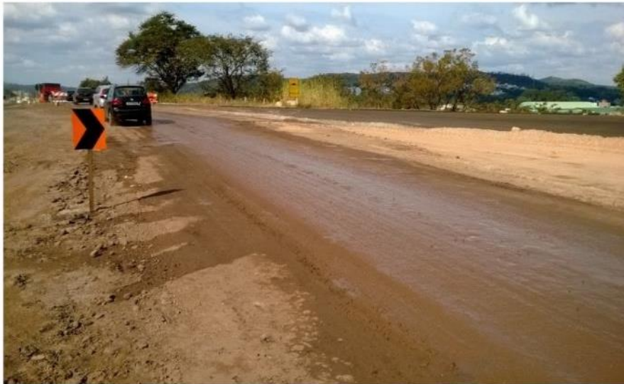
Aspersão de água nas vias da obra/ detalhe de varrição mecânica na via
