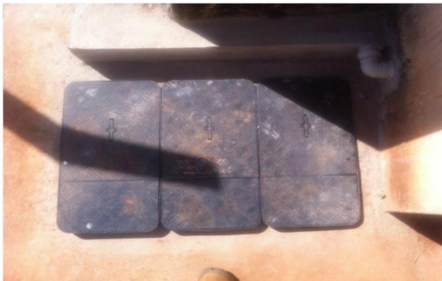
Vista do canteiro de obras da empresa Ideal (Duplicação de Azurita ITV 17-22) - detalhe da caixa SAO
