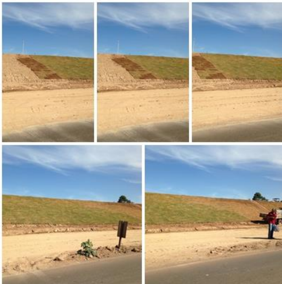
Foto 7.4.6.4-3: Km 84,7 - 89,5 - Duplicação de Itaúna. Talude com cobertura vegetal sendo implantada.
