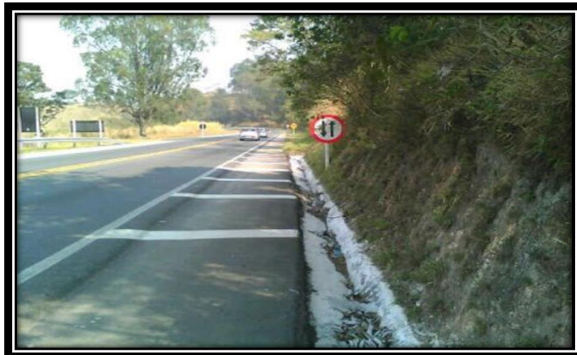
RODOVIA MG-050 KM 175,1 LD ANTES EVENTO 14628/14
