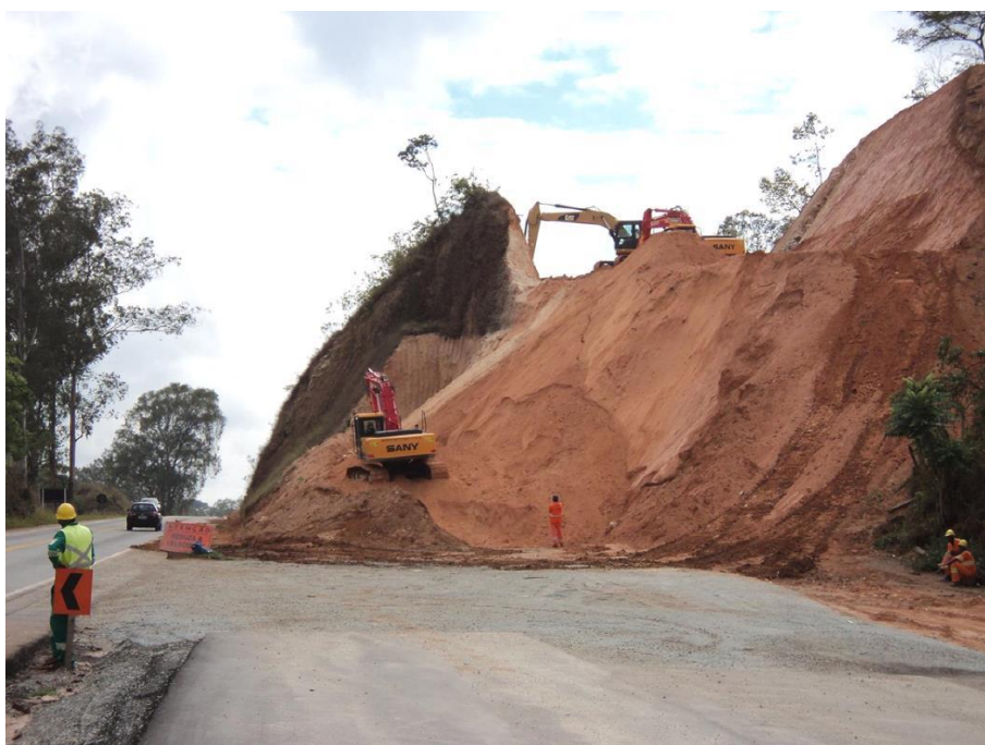
Foto 7.4.2.4-5: Área de corte da obra de duplicação de Azurita (ITVs 17-22) do Km 69,11 – 75,68.
