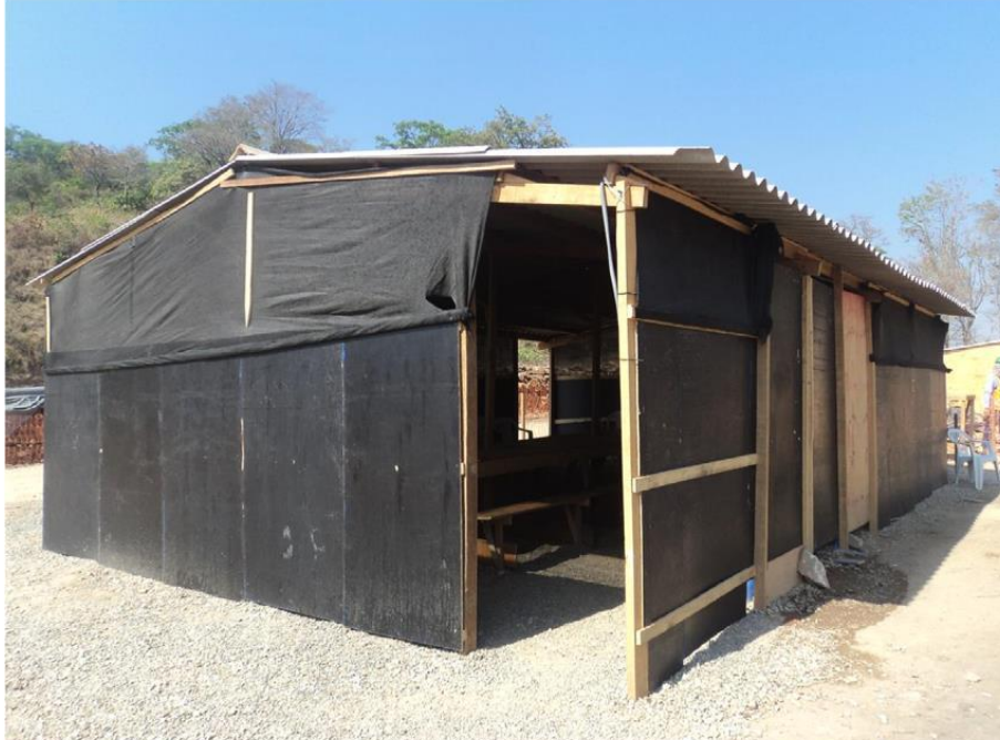
Foto 7.4.2.4-6: Canteiro de obras para a correção de traçado e implantação de 3ª Faixa (ITV 159-160) do Km 375,32 – 378,151.
