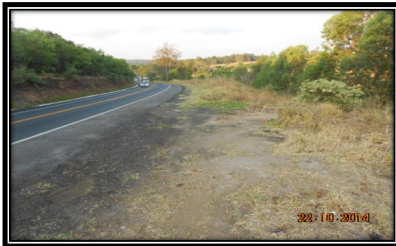
RODOVIA MG-050 KM 180,9 LE DEPOIS EVENTO 14640/14
