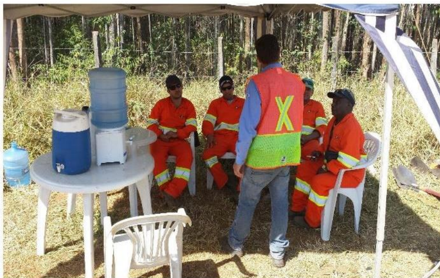
Vista do canteiro de obras da empresa Pavidez (Terceira faixa ITV 90) - detalhe da área de vivência com água potável
