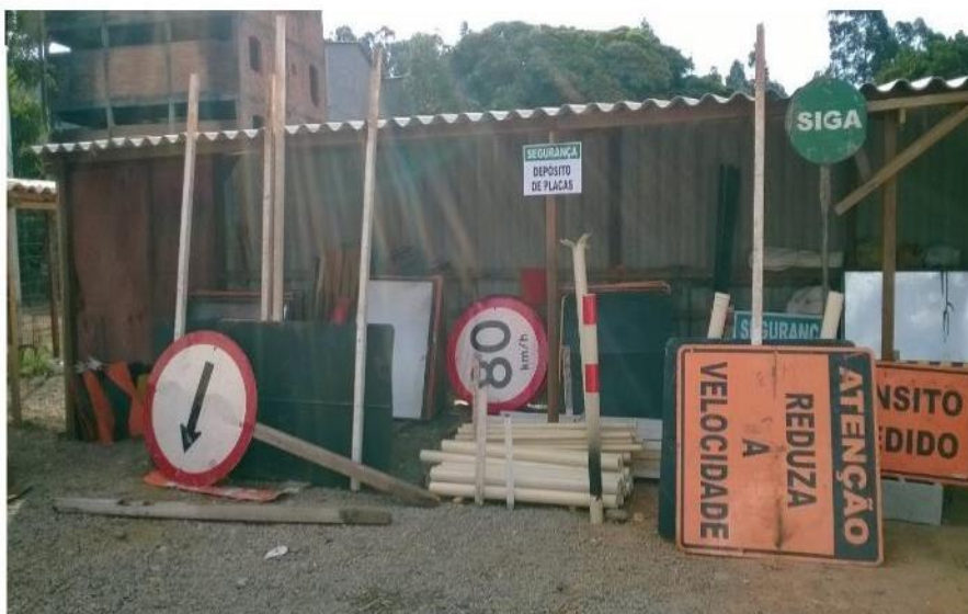
Vista do canteiro de obras da empresa ECB (Duplicação de Itaúna ITV 27-31) - detalhe no acondicionamento temporário de materiais utilizados na obra
