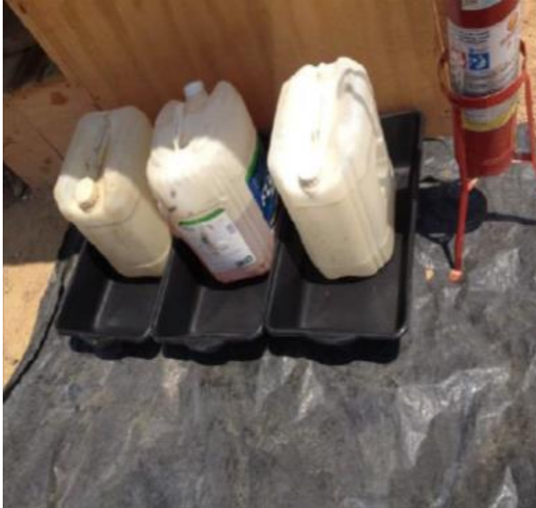
Foto 7.4.5.4-1: Armazenamento temporário para manuseio de produto químico.
