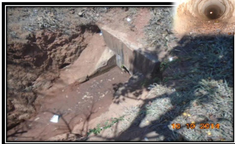
RODOVIA MG-050 KM 112,6 LE -DEPOIS EVENTO 13960/14
