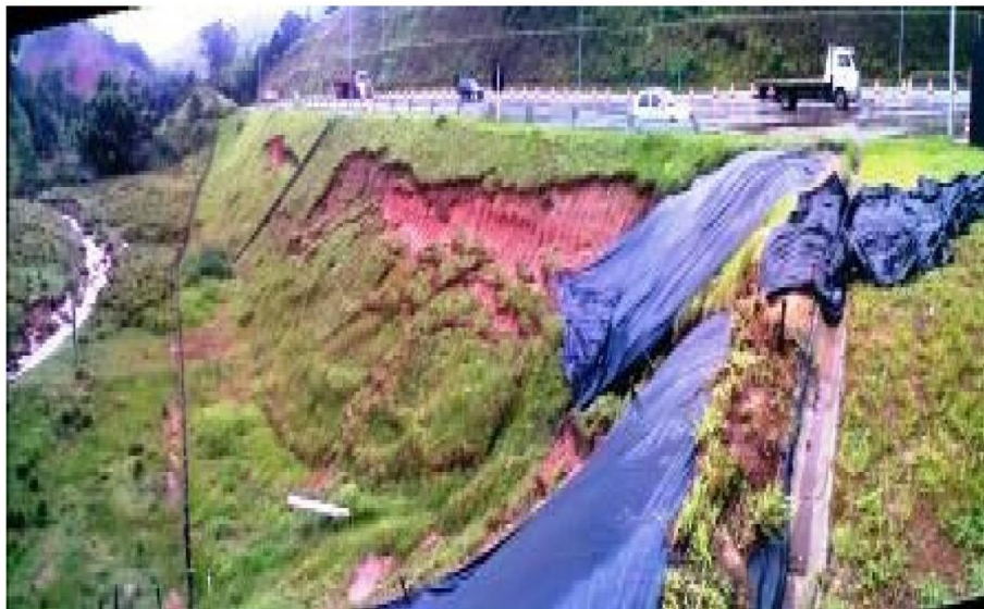
Vista do processo erosivo no km 81 (LE) - Antes
