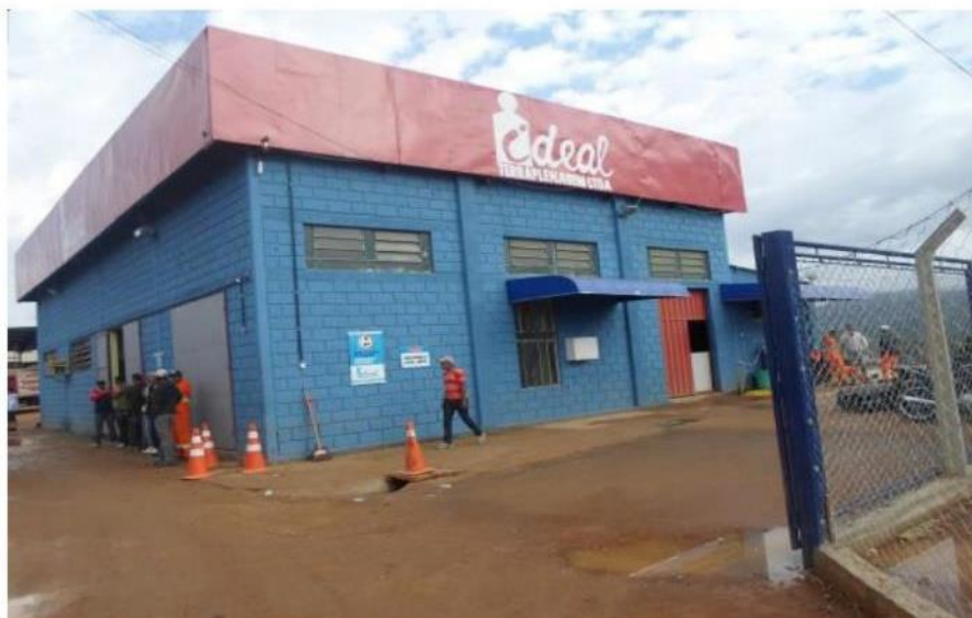
Vista do canteiro de obras da empresa Ideal (Duplicação de Azurita ITV 17-22) - detalhe do galpão e cercamento da área
