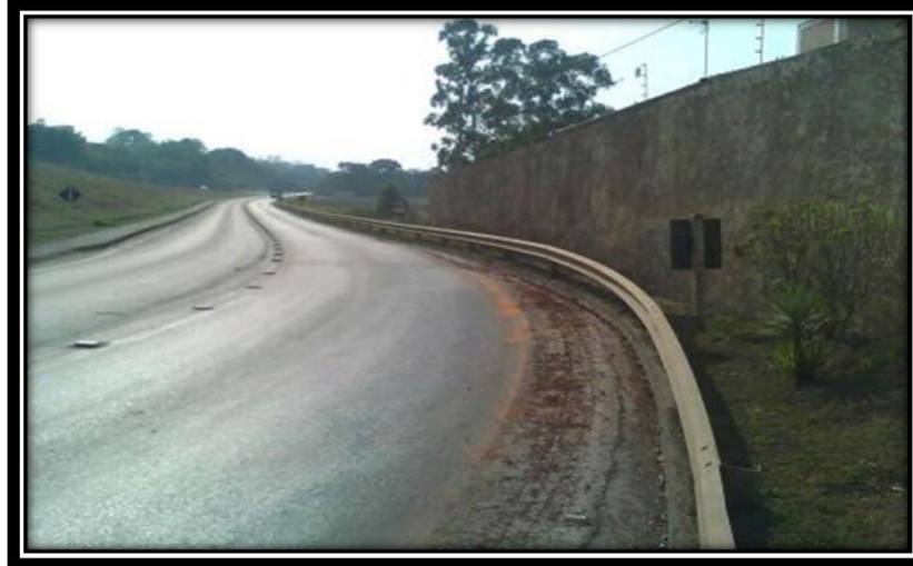
RODOVIA MG-050 KM 211,9 LE ANTES EVENTO 14649/14
