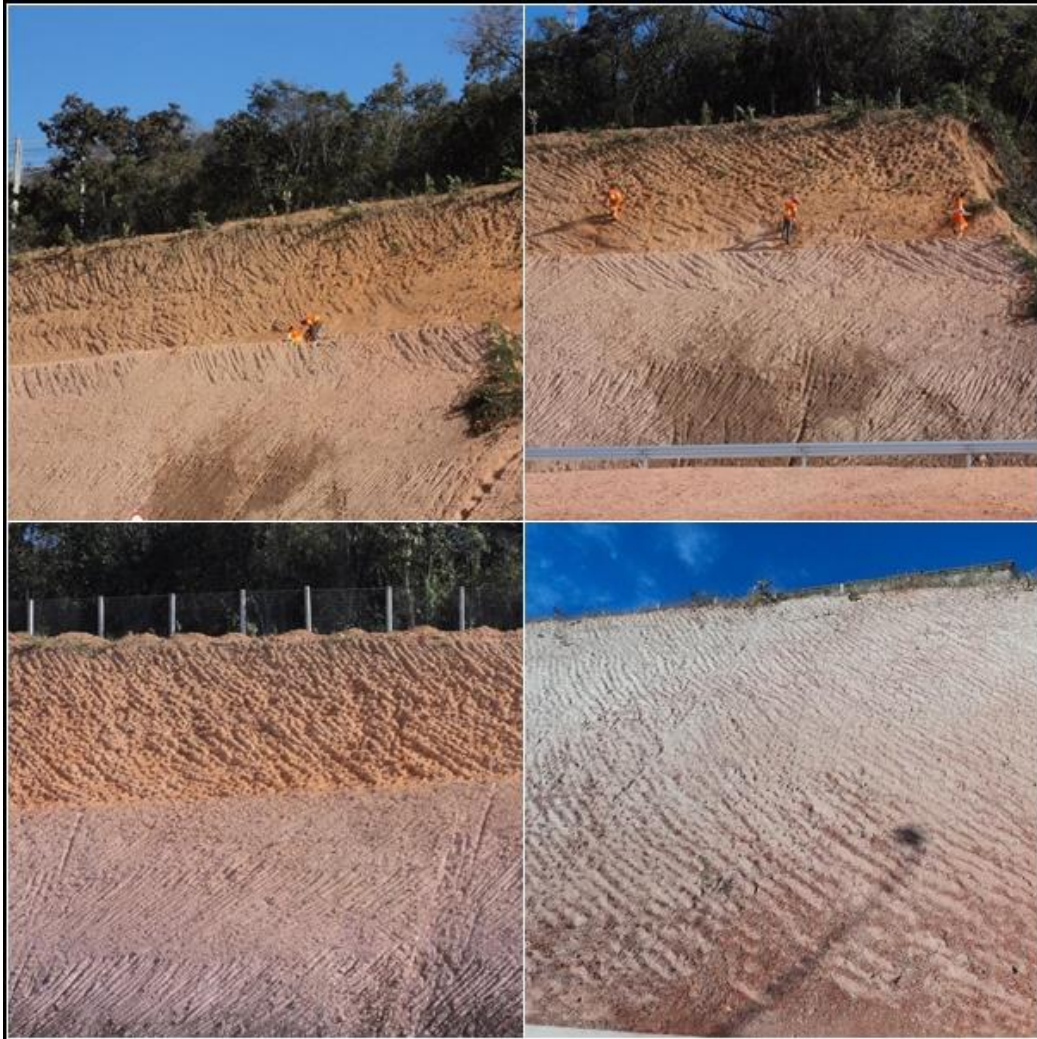
Foto 7.4.6.4-2: Km 84,7 - 89,5 - Duplicação de Itaúna. Exemplo de preparação o talude para hidro-semeadura.
