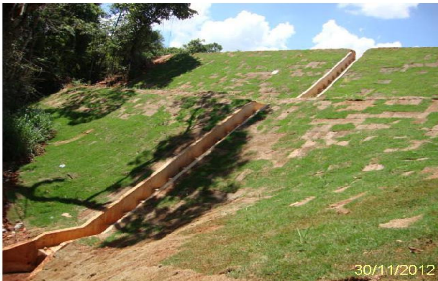
Vista da recuperação do processo erosivo no km 99,80 (LE) - Depois
