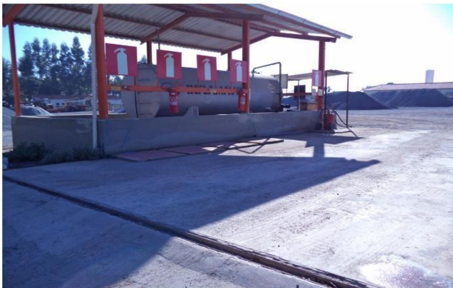
Vista do canteiro de obras da empresa Pavidez - detalhe do tanque de armazenamento de combustível com dique de proteção
