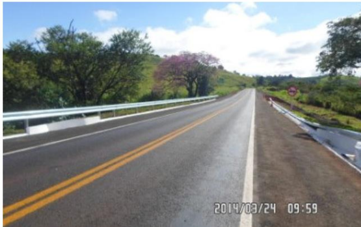
Data da verificação: Implantação de acostamento março-14
