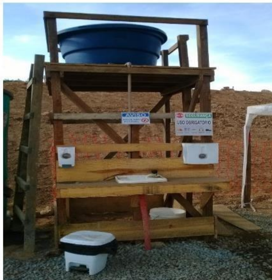
Vista do canteiro de obras da empresa ECB (Duplicação de Itaúna ITV 27-31) - detalhe da área de vivência e do lavabo para os colaboradores
