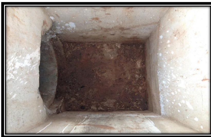
RODOVIA BR-265 KM 650,7 LE -DEPOIS EVENTO 14624/14
