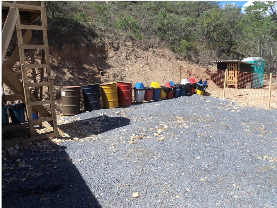
Foto 7.4.12.4-3: Lixeiras para armazenamento de resíduos domésticos na frente de serviço das obras de correção de traçado e implantação de 3ª Faixa (ITV 125) do Km 293,4 – 296,85,151, sob responsabilidade da ECB.
