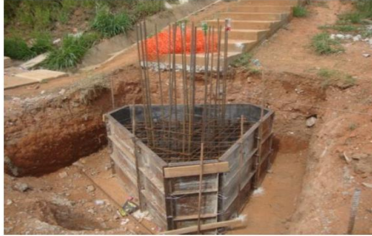
Implantação de passarela no km 62,840 abril-14
