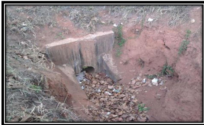
RODOVIA MG-050 KM 112,6 LE - ANTES EVENTO 13960/14
