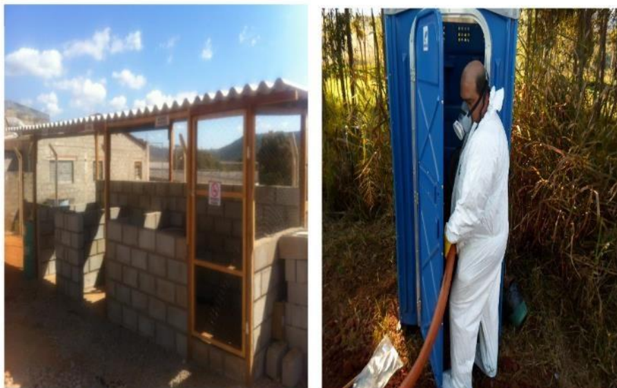
Vista do canteiro de obras da empresa Ideal (Duplicação de Azurita ITV 17-22) - detalhe da bala de acondicionamento temporário de resíduos recicláveis/ limpeza de sanitário químico
