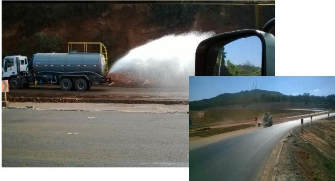
Aspersão de água nas vias da obra/ detalhe de varrição mecânica na via
