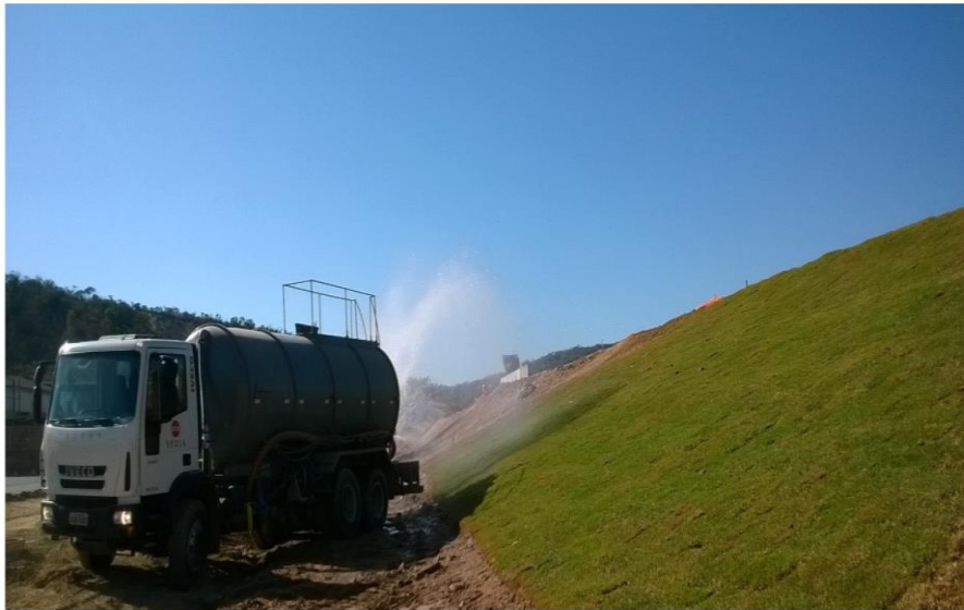
Vista da irrigação da grama plantada
