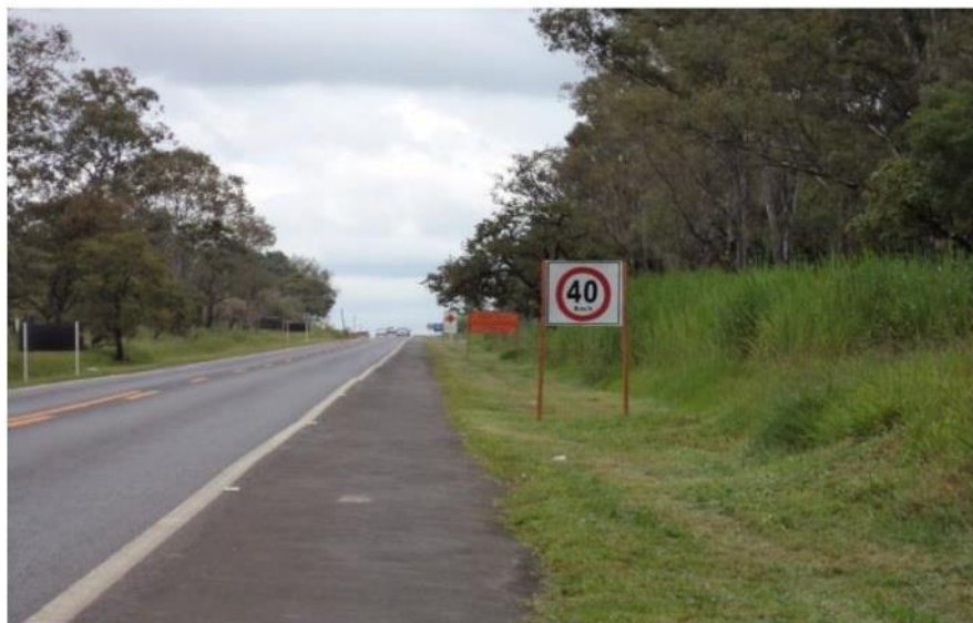
Vista das placas de limite de velocidade nos trechos em obras (ITV 90)
