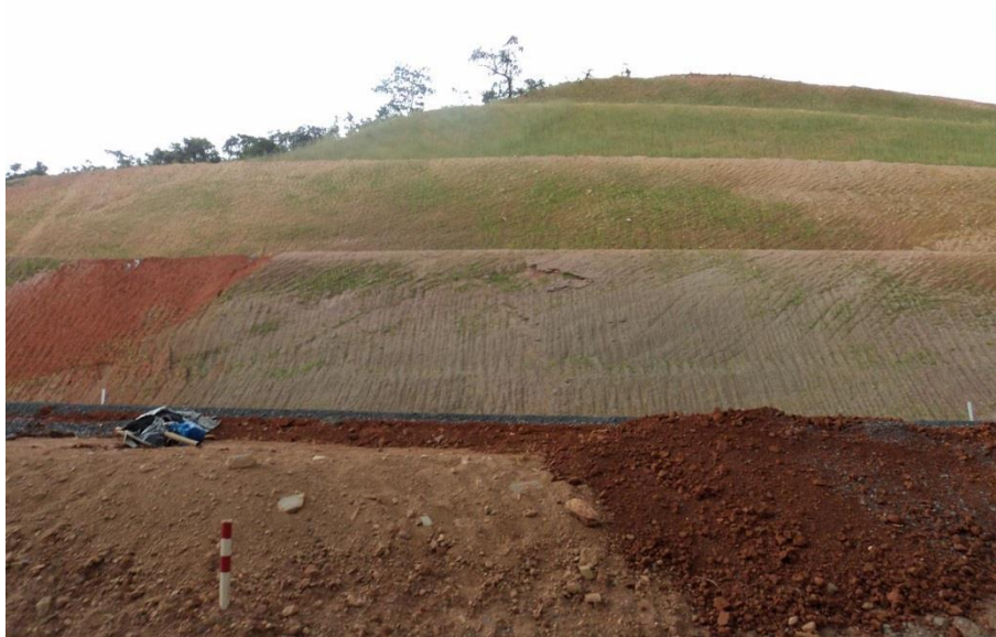
Foto 7.4.11.4-1: Cobertura vegetal por hidro-semeadura de talude de corte das obras de Correção de traçado e implantação de 3ª Faixa (ITV 125) 293,4 – 296,85.
