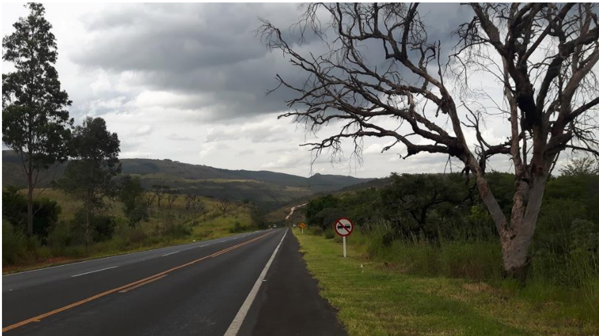
Foto 7.4.2.4-1: Exemplar arbóreo morto localizado no Km-300,420 LE, objeto de supressão de rotina e manutenção da segurança viária.
