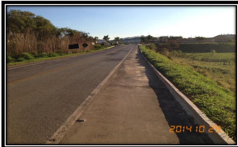
RODOVIA MG-050 KM 264,45 LD DEPOIS EVENTO 14960/14
