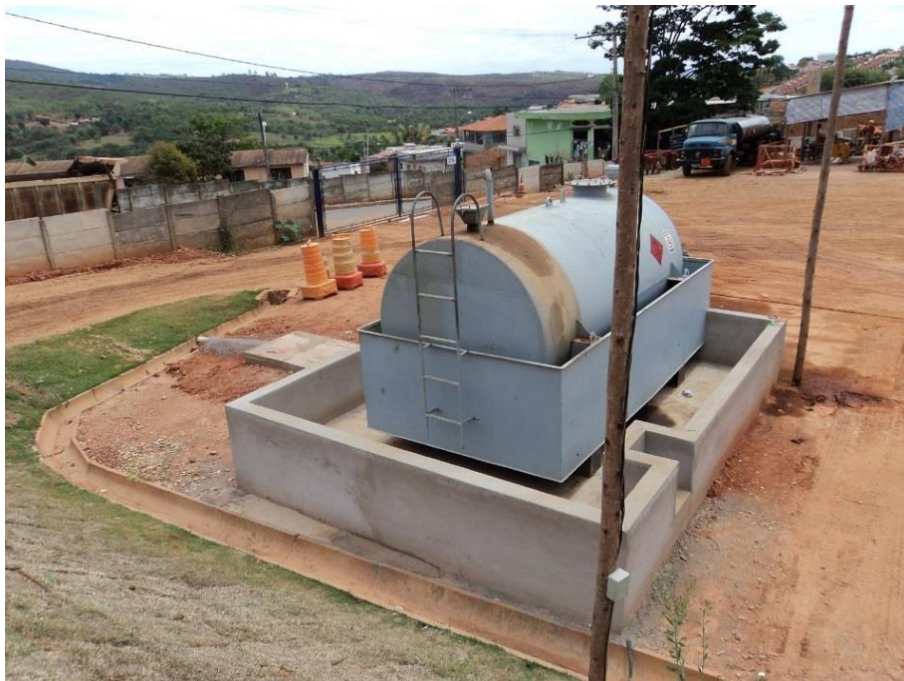
Foto 7.4.5.4-2: Tanque de abastecimento interno.
