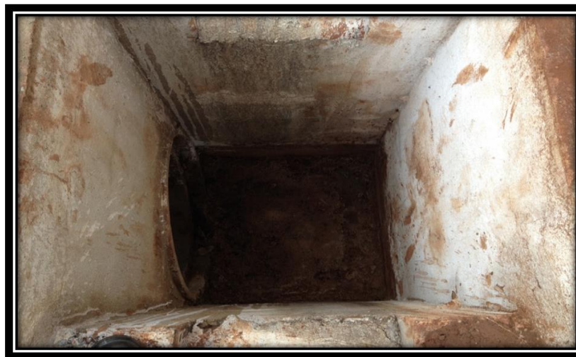
RODOVIA BR-265 KM 650,6 LE -DEPOIS EVENTO 14623/14
