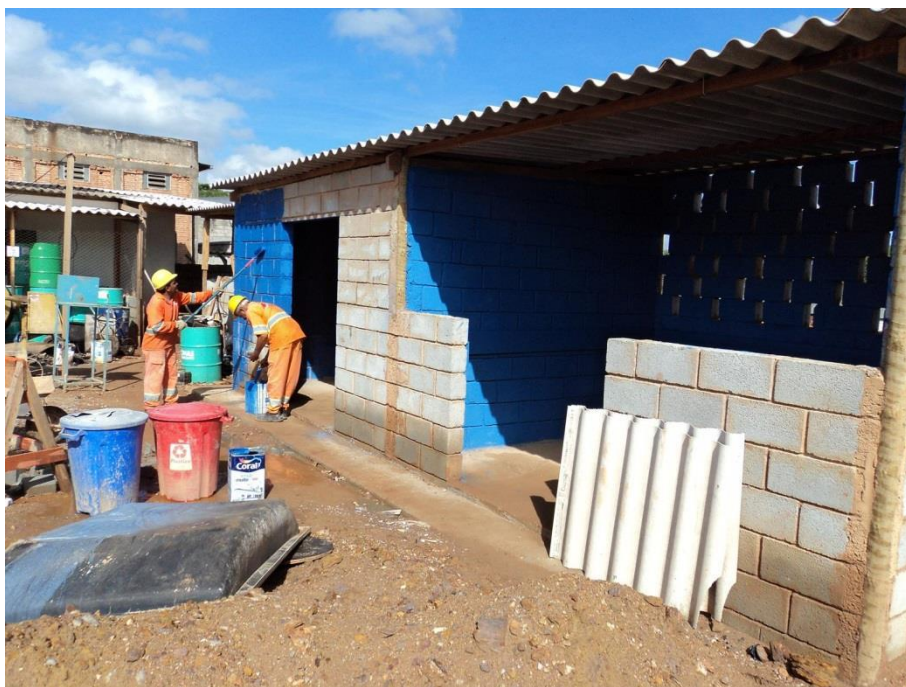
Foto 7.4.2.4-13: Pátio da Empresa IDEAL, em Mateus Leme-MG. Construção de baias de armazenamento de resíduos.
