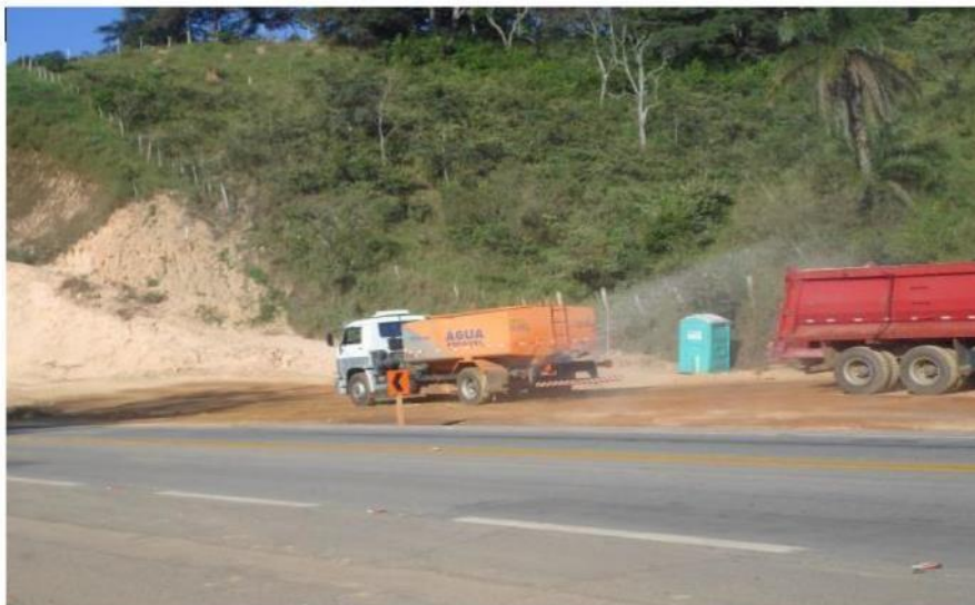
Aspersão de água nas vias da obra
