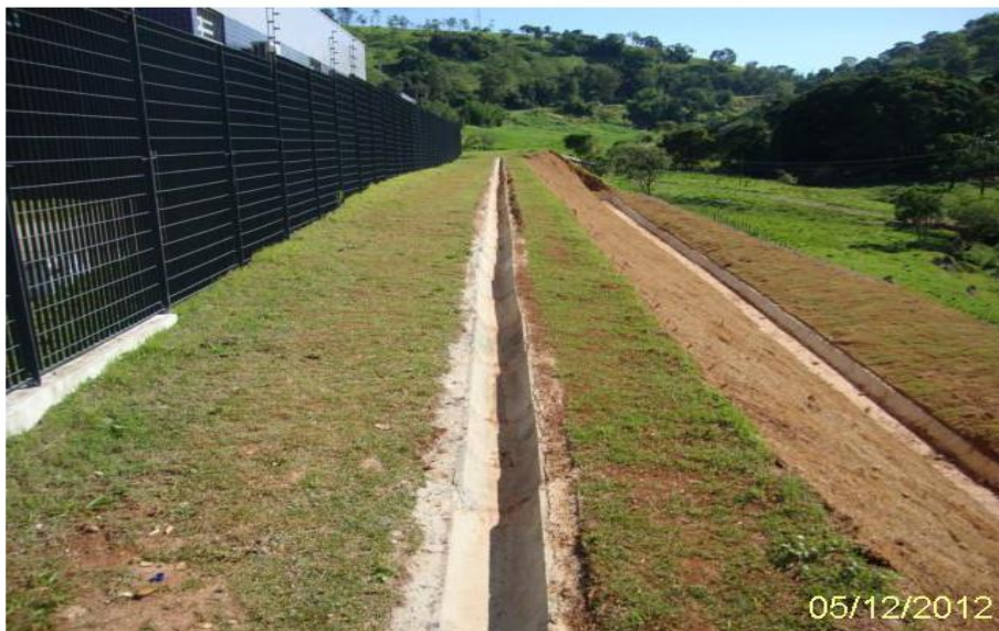
Vista do processo erosivo no km 81 (LE) - Depois
