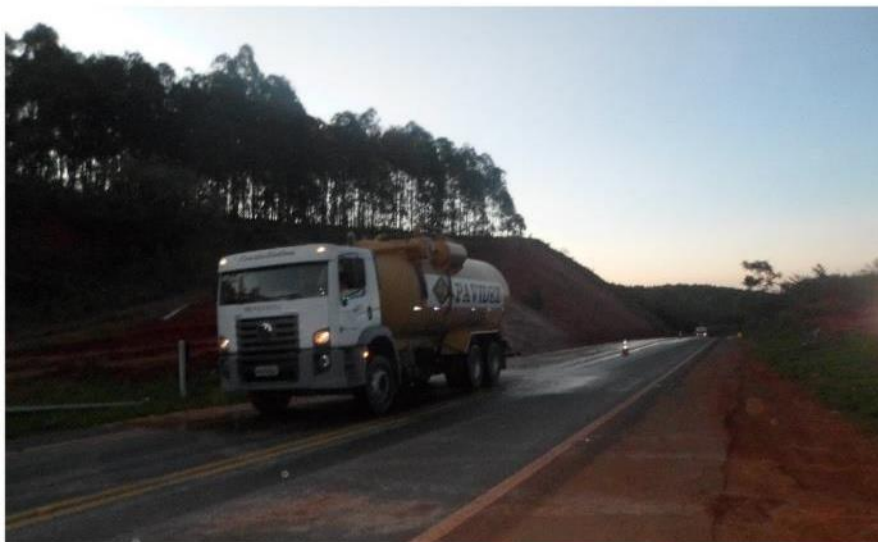
Aspersão de água nas vias da obra
