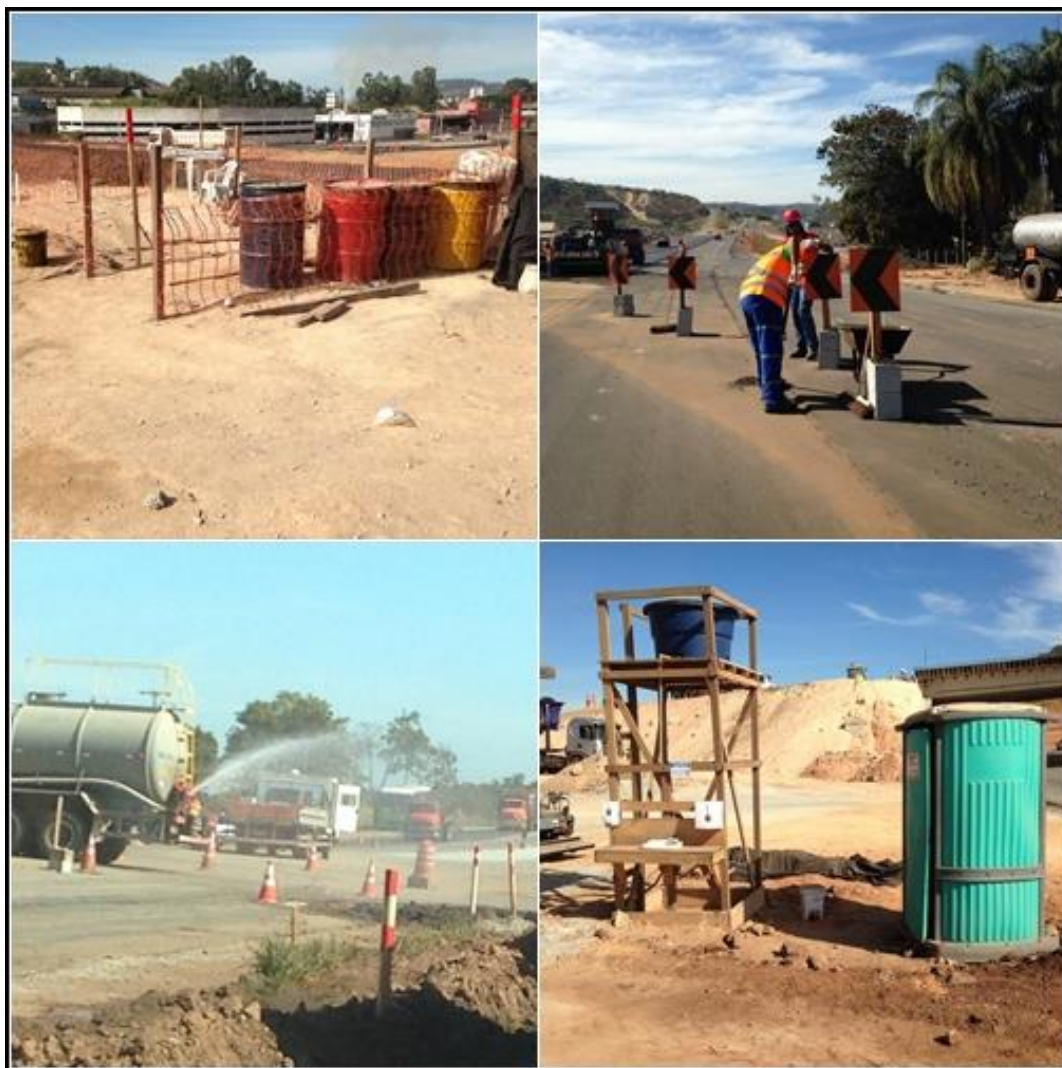
Figura 7.4.5.4-1: Km 84,7 - 89,5 - Duplicação de Itaúna - Boas práticas em canteiros de obra.
