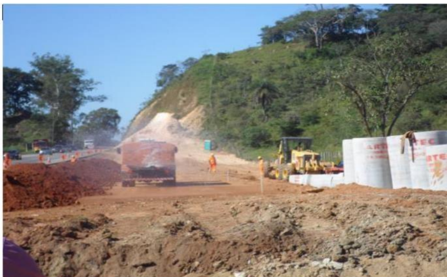
Aspersão de água nas vias da obra
