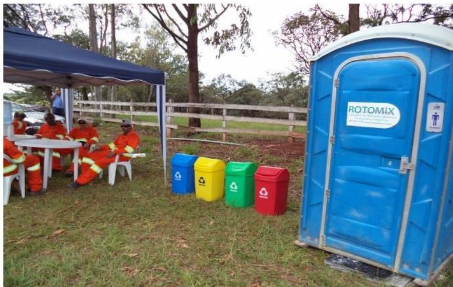
Vista do canteiro de obras da empresa Pavidez (ITV 90) - detalhe da área de vivência com sanitário e lixeiras de coleta seletiva
