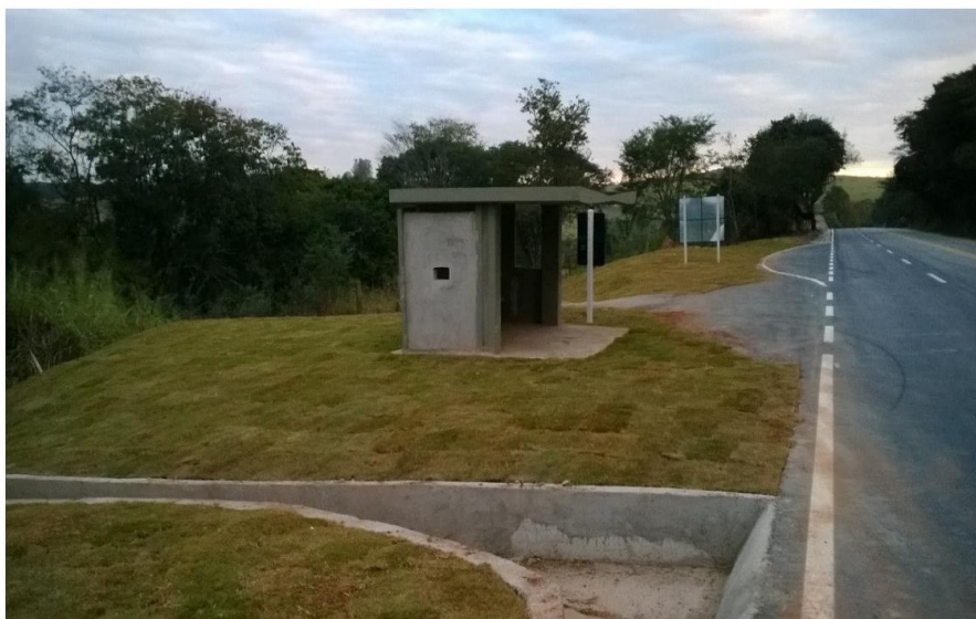
Revestimento vegetal (tipo grama em placa) executado em talude de aterro nas proximidades da parada de ônibus
