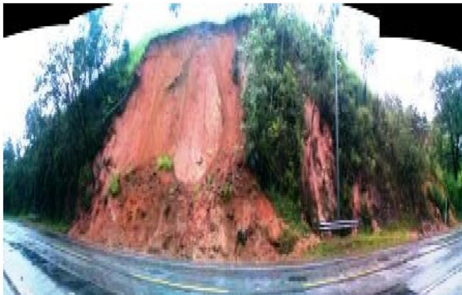
Vista do processo erosivo no km 131 (LD) - Antes
