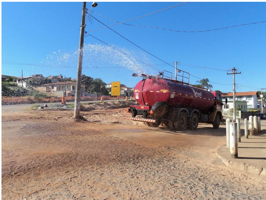
Foto 7.4.3.4-4: Umectação da via das obras de duplicação de Azurita do Km 69,11 – 75,68 sob responsabilidade da empresa Ideal.
