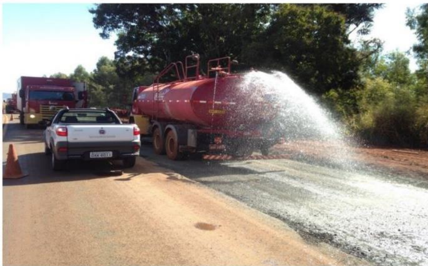
Aspersão de água nas vias da obra
