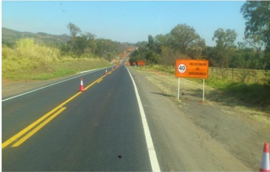
Vista das placas de limite de velocidade nos trechos em obras (ITV 181)
