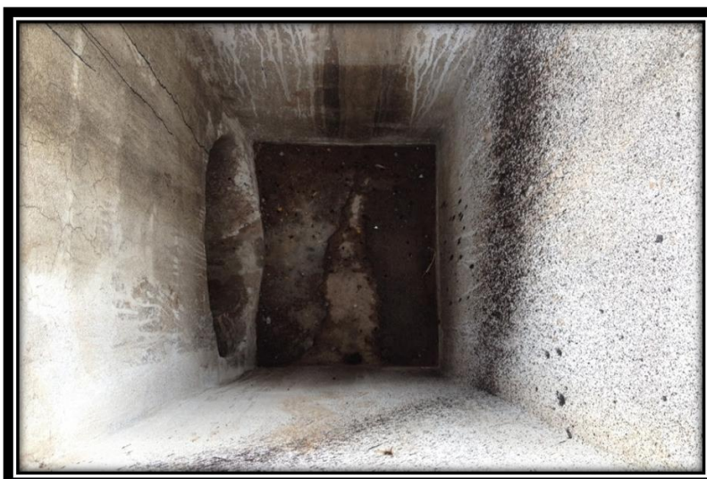
RODOVIA BR-265 KM 647,05 LD -DEPOIS EVENTO 14621/14
