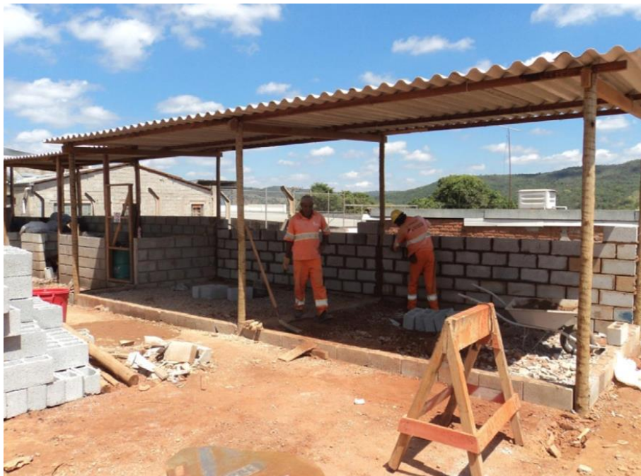
Foto 7.4.2.4-9: Construção de baias para resíduos da construção civil.
