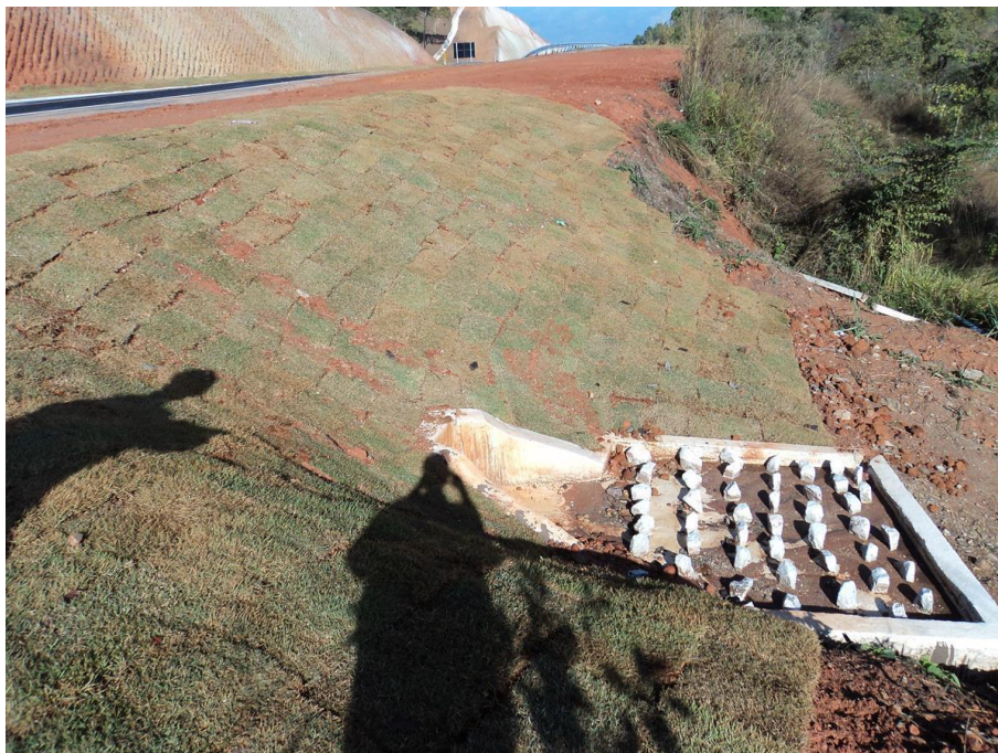
Foto 7.4.11.4-2: Cobertura vegetal de aterro das obras de Correção de traçado e implantação de 3ª faixa (ITV 66) do Km 141 – 142,5, sob responsabilidade da empresa ECB
