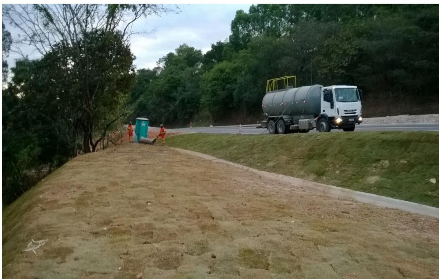
Vista da irrigação da grama plantada
