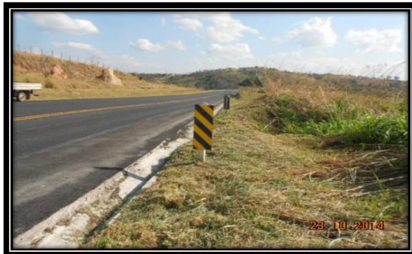
RODOVIA MG-050 KM 156,4 LD DEPOIS EVENTO 14811/14
