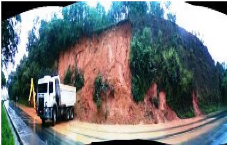
Vista do processo erosivo no km 170 (LE) - Antes
