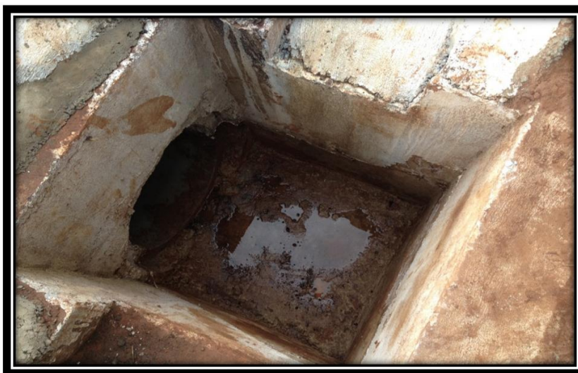
RODOVIA BR-265 KM 650,52 LE -DEPOIS EVENTO 14622/14
