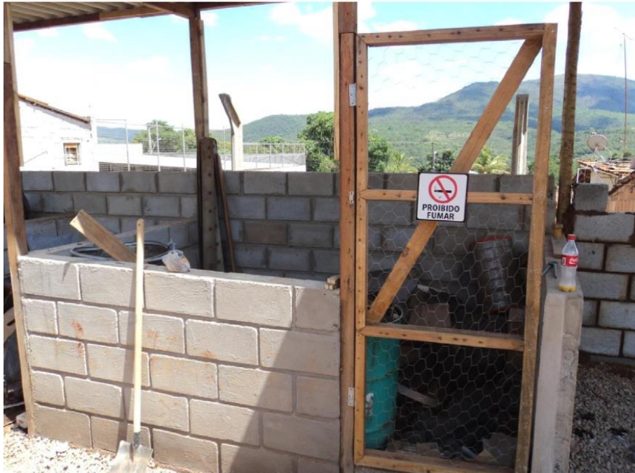
Foto 7.4.2.4-8: Baia em construção para armazenamento de resíduos classe D da construção civil.
