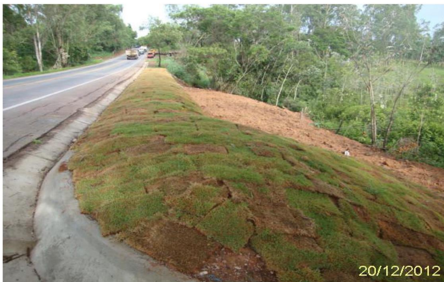
Vista do processo erosivo no km 112 (LD) - Depois
