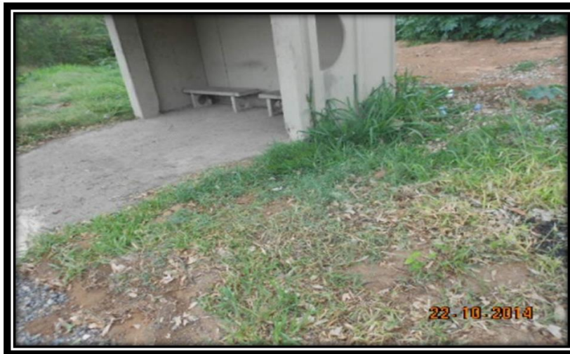
RODOVIA MG-050 KM 203,2 LE DEPOIS EVENTO 14650/14
