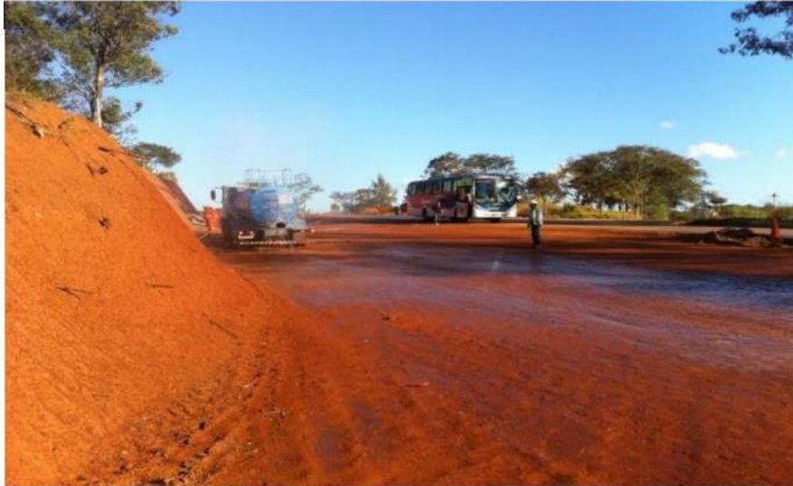
Aspersão de água nas vias da obra
