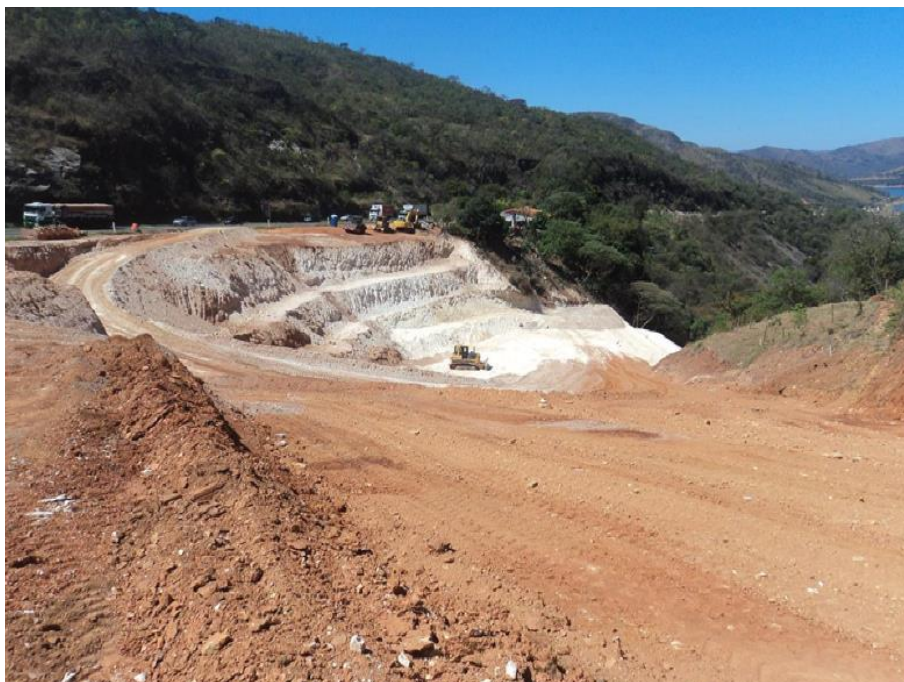
Foto 7.4.2.4-4: Correção de traçado e implantação de 3ª Faixa ITV 125 no Km 293,4 ao 296,85 executada pela empresa ECB, mostra uma área de bota fora e de aterro respectivamente.
