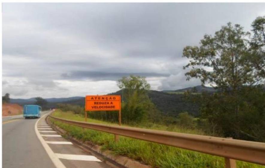
Vista das placas de limite de velocidade nos trechos em obras (ITV 17-22)
