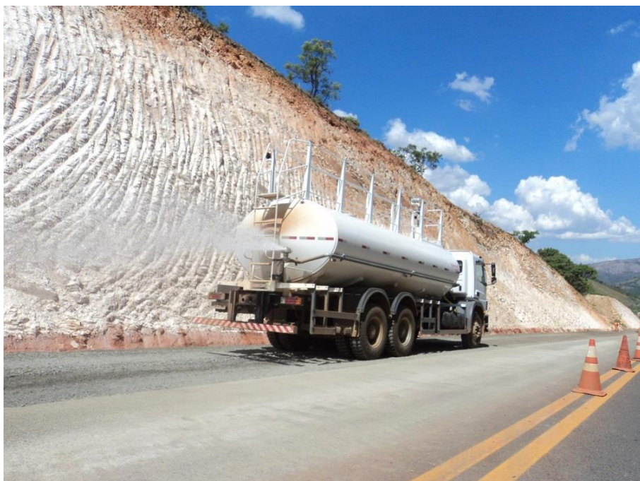
Foto 7.4.3.4-2: Umectação da via das obras de correção de traçado e implantação de terceira faixa ITV 125 do Km - 293,4 - 296,85 de responsabilidade da empresa ECB.
