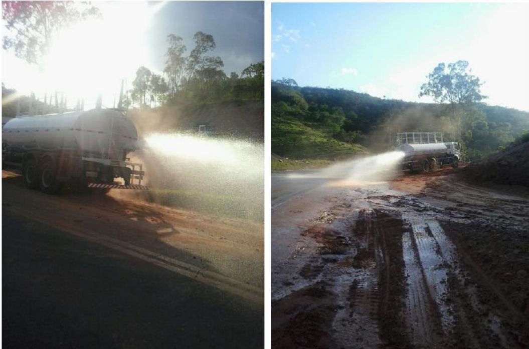
Foto 7.4.3.4-3: Umectação da via das obras de correção de traçado e implantação de 3ª Faixa (ITV 125) do Km 293,4 – 296,85 de responsabilidade da ECB.
