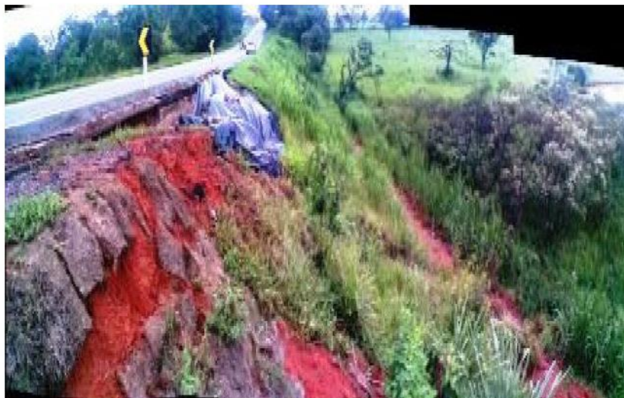
Vista do processo erosivo no km 103 (LD) - Antes
