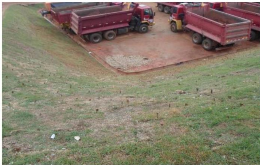
Vista do canteiro de obras da empresa Ideal (Duplicação de Azurita ITV 17-22) - detalhe do revestimento vegetal do talude e elementos de drenagem instalados
