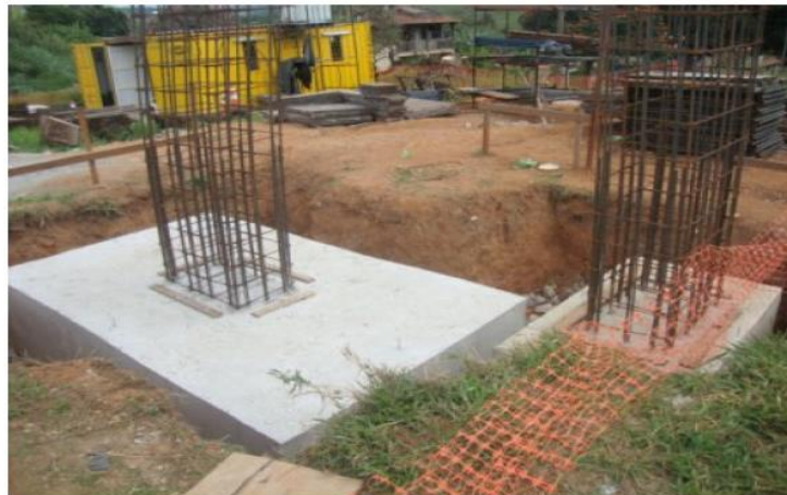
Implantação de passarela no km 62,840 abril-14
