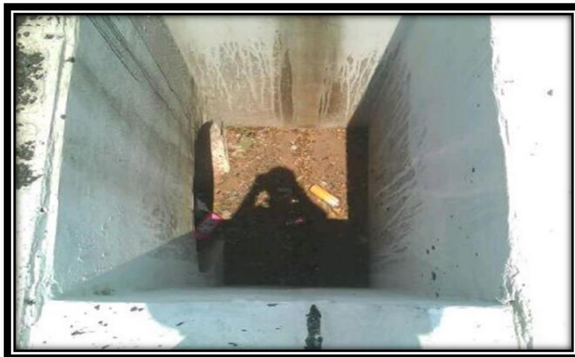
RODOVIA BR-265 KM 647,05 LD - ANTES EVENTO 14621/14
