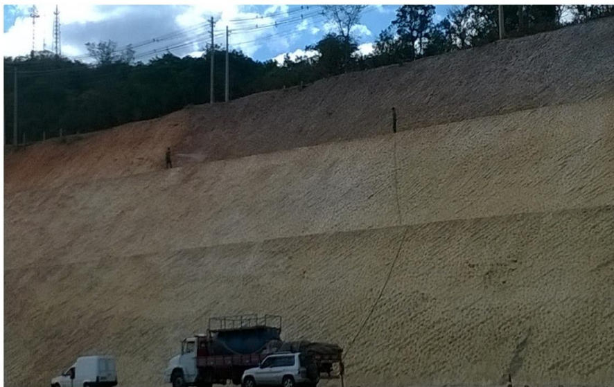
Aplicação de hidrossemeadura em talude de corte
