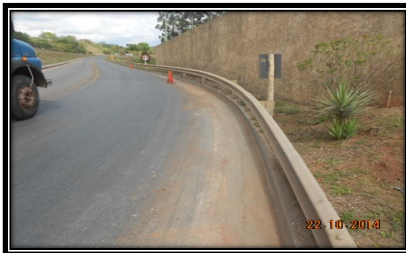
RODOVIA MG-050 KM 211,9 LE DEPOIS EVENTO 14649/14
