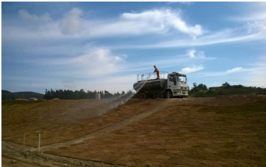
Vista da irrigação da grama plantada
