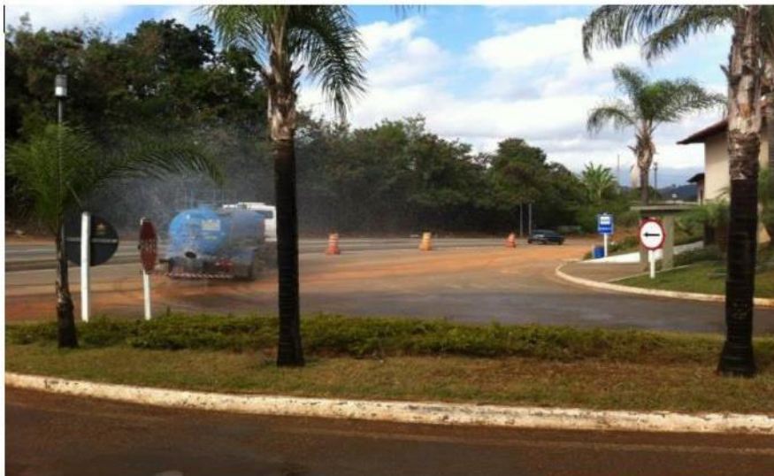
Aspersão de água nas vias da obra
