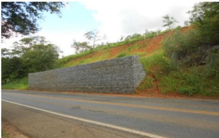
Vista do processo erosivo no km 221,50 (LE) - Depois
