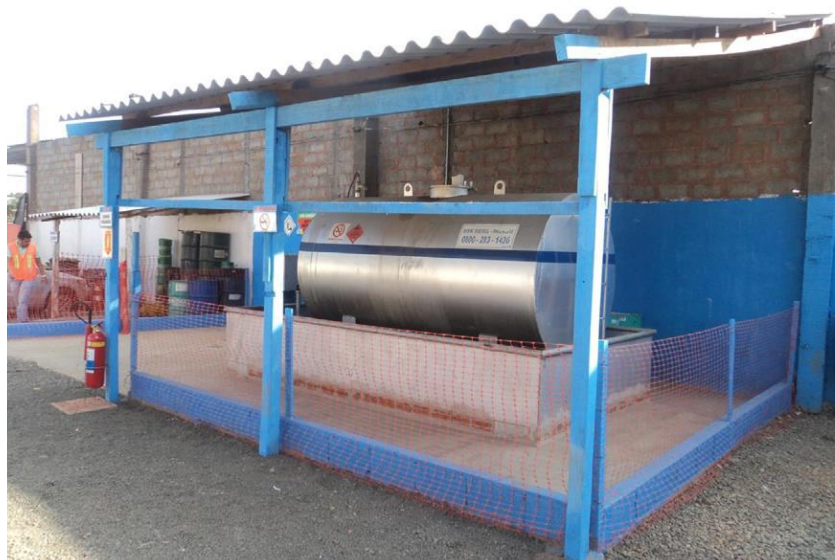
Foto 7.4.12.4-9: Local do tanque de abastecimento dos maquinários.
