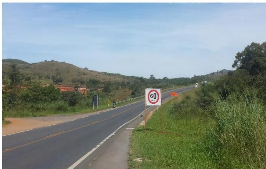
Vista das placas de limite de velocidade nos trechos em obras (ITV 115)
