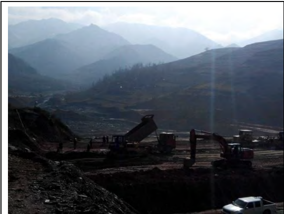
文祖口水库施工现场
