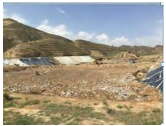
乐都区生活垃圾填埋场一、二区
