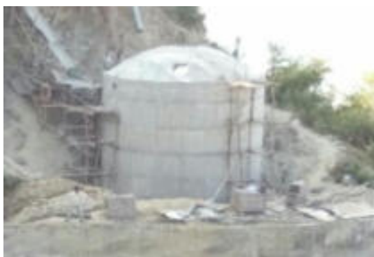
200 KL Water Tank
