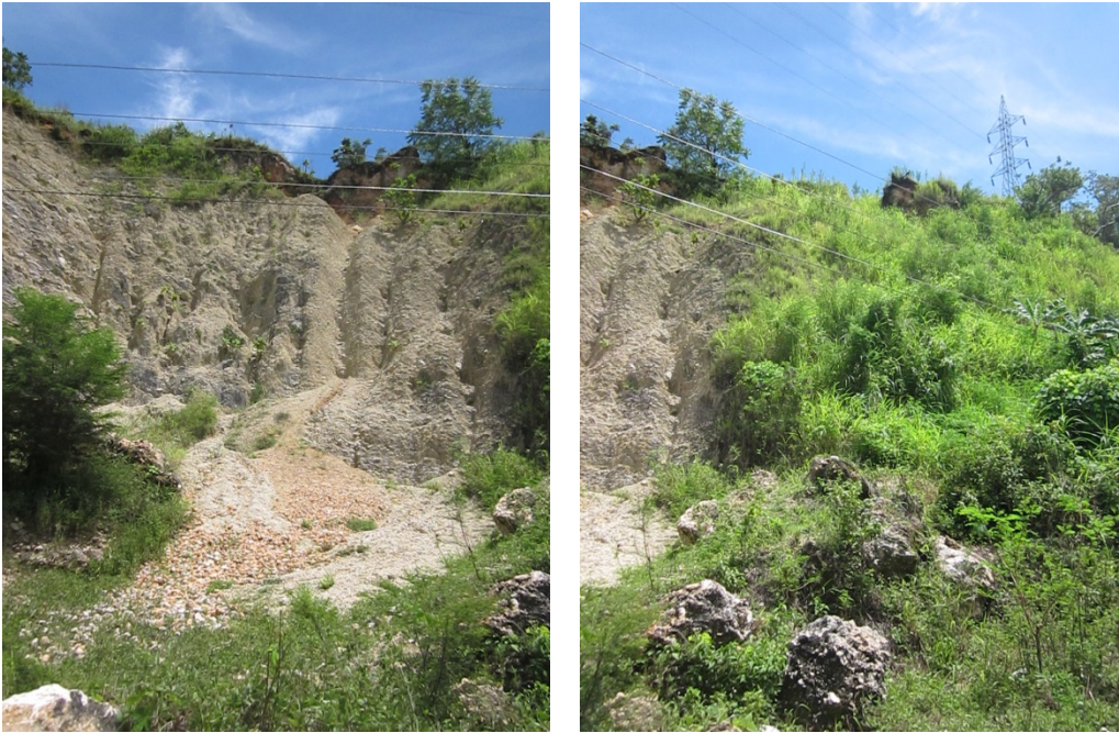
Photo 2 et Photo 3 Décrochement de la paroi de la falaise à proximité du pylône 6
