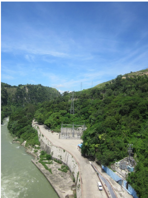
Photo 14 Début de la ligne à 115 kV Péligre – Nouveau Delmas à la centrale hydroélectrique de Péligre
