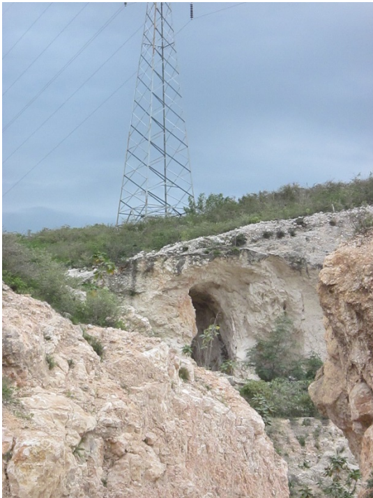
Photo 1 Pylône 97 dont la structure est fragilisée en raison de l'exploitation de la carrière de calcaire
